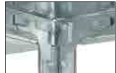
Aussteifung mit Eckplatten
